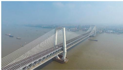
太湖山トンネルは3618mで断層が多く複雑で、同時に太湖山国家級森林公園を通るため環境にも配慮が必要なトンネルです。また蕪湖長江三橋は上部が車道、下部に高速鉄道が通り、「1つの世界1、2つの中国最先端、10のイノベーション、20の特許」技術を駆使して建設しています。
